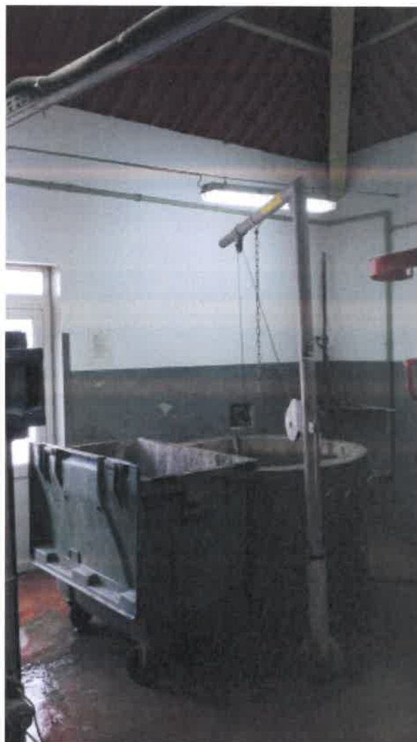
Krata ręczna i kontener na skratki
