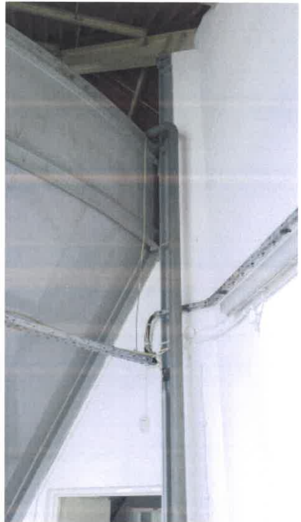
Wspólny rurociąg z pompowni wewnętrznej
