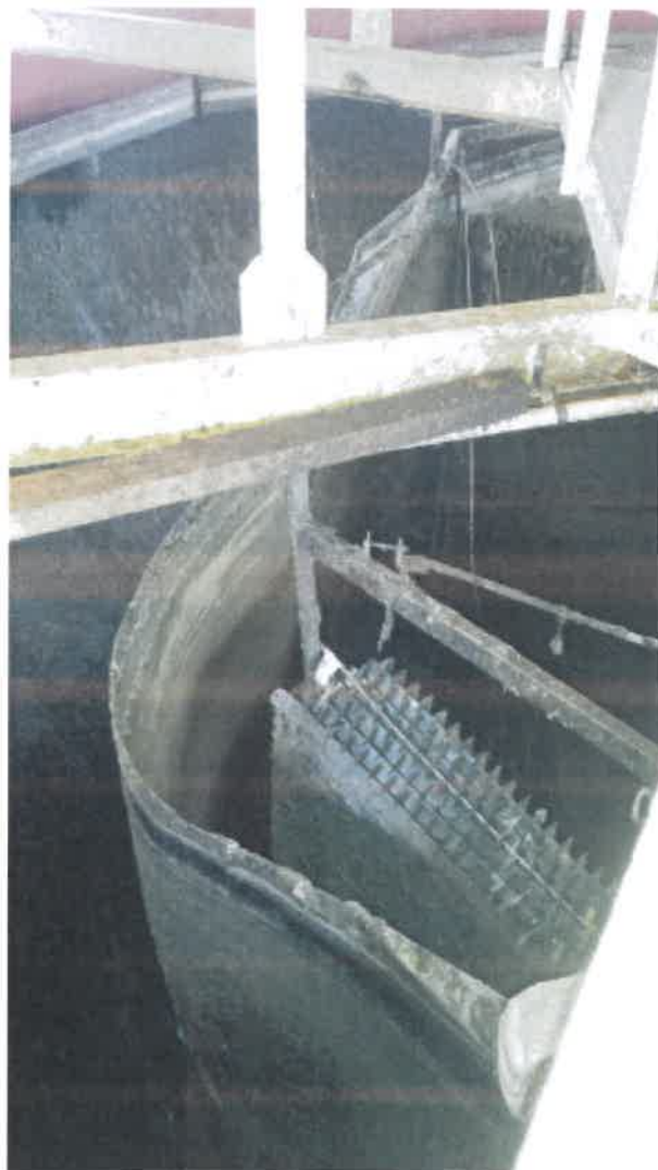
Stalowa ściana osadnika, konstrukcja wsporcza oraz złoża biologiczne
